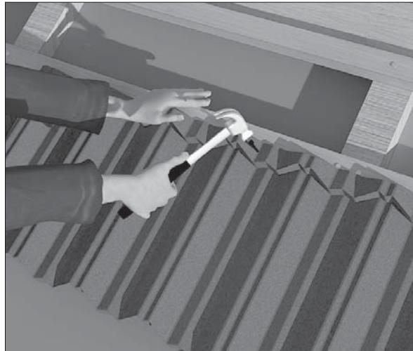
Черепица укладывается посредством подъема обеих кровельных листов в ряду и запуска следующий ряд под уже установленную черепицу. Начиная укладку от уже уложенного ряда, укладывайте два ряда одновременно от края до края. Кровельщик, укладывающий черепицу, должен быть на два ряда впереди от того, кто забивает гвозди.
