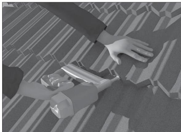
Правильное расположение гвоздей для разных профилей черепицы указано на рисунках ниже. При указанных требованиях гарантируется хорошая фиксация черепицы и проникновение гвоздя на максимальную длину через две толщины листов черепицы.
